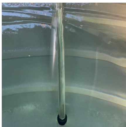
Vista al interior del estanque
