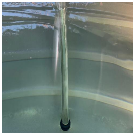
Vista al interior del estanque
